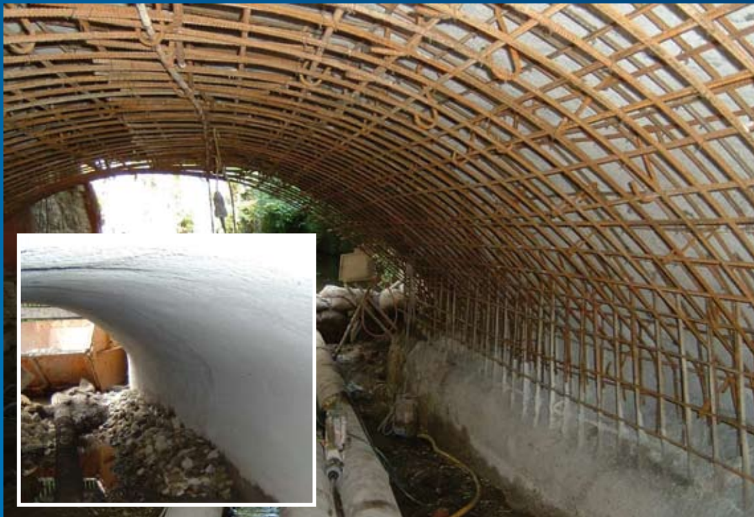
Selbst bei einer Sanierung der Brücke ginge die Steinsichtigkeit weitgehend verloren. Um eine Auflastung der Brücke zu erreichen, müsste von unten eine statisch wirksame Spritzbetonschale eingebaut werden. Die Fotos wurden vom Fachbüro Drilling & Schneider (Delbrück) zur Verfügung gestellt, das für die Stadt Delbrück mehrere Lösungen für die „Hohe Brücke“ ausgearbeitet hat, und zeigt die Instandsetzung einer Gewölbebrücke über die Werre in Horn-Bad Meinberg.
