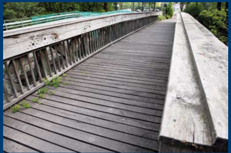
Wegen der kurzen Sanierungsintervalle würde nach heutigem Stand der Technik die Holzbrücke nicht mehr saniert, sondern durch eine Alu- oder Betonkonstruktion ersetzt.
